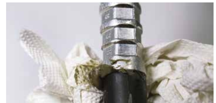
Bild 8: 1. Isolation entfernen, 2. Leiter reinigen, 3. Leiter einführen, 4. Sechskant Verpressung, 5. Kontaktfett entfernen
